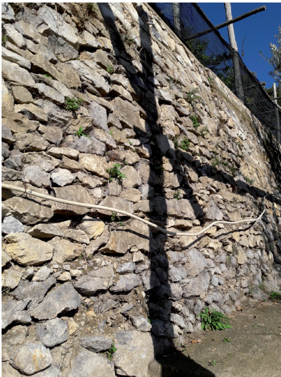
Nella foto macera realizzata interamente con pietre a faccia vista.
