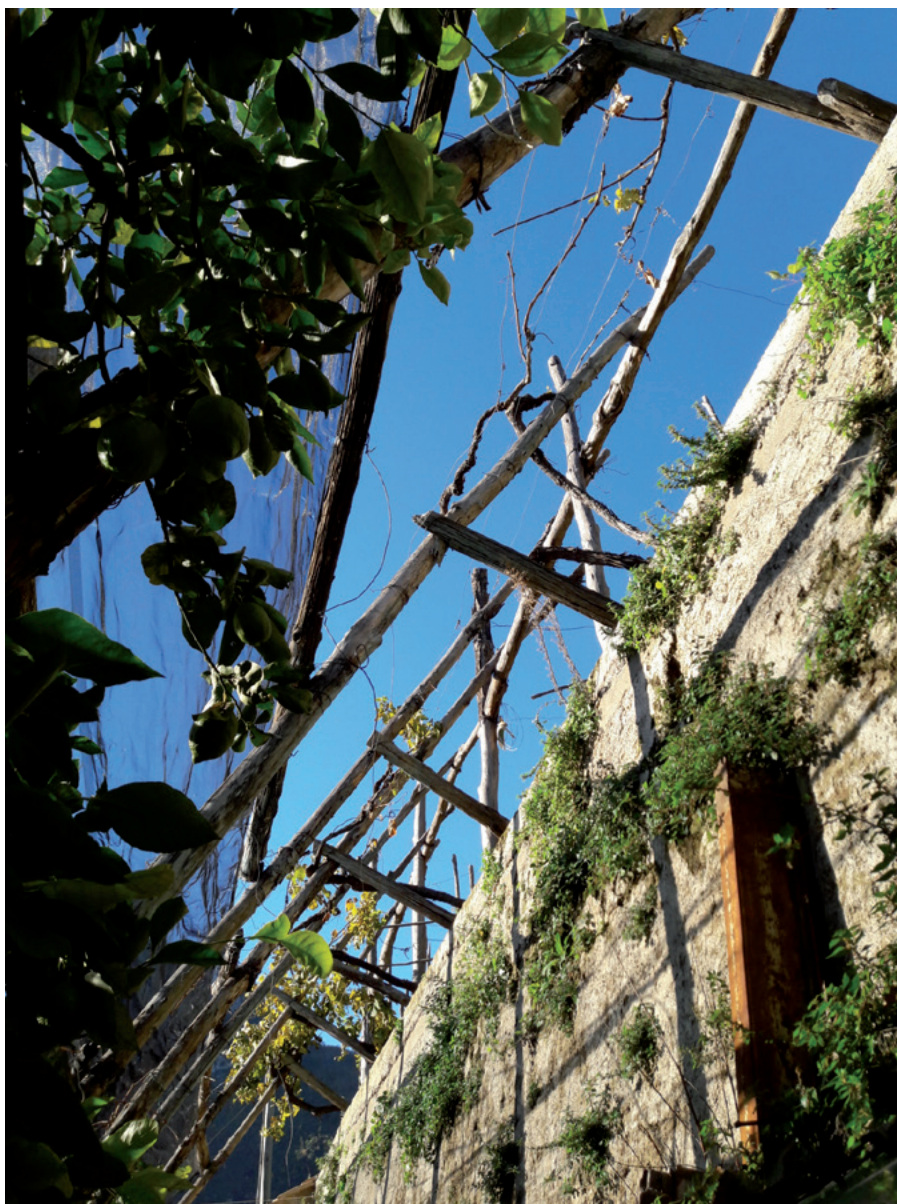
Nella foto le pertiche longitudinali della “spalliera”.
